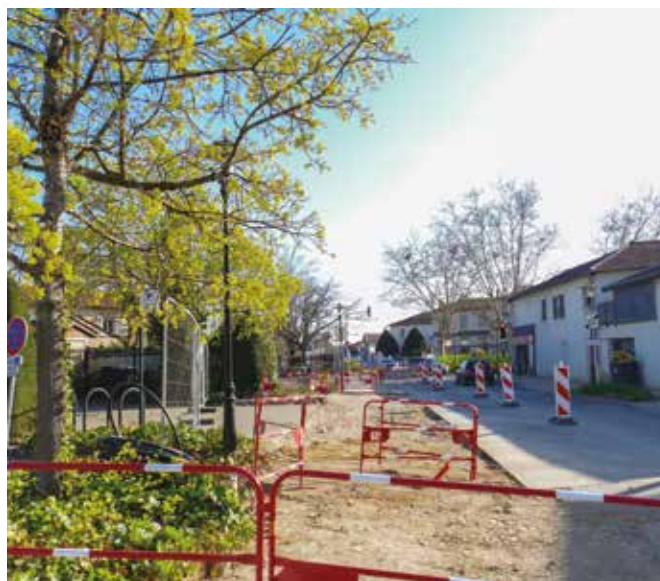
Travaux rue Roybet - Genas
