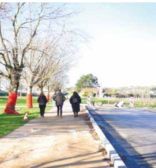
Travaux entrée de ville - Saint Pierre de Chandieu
