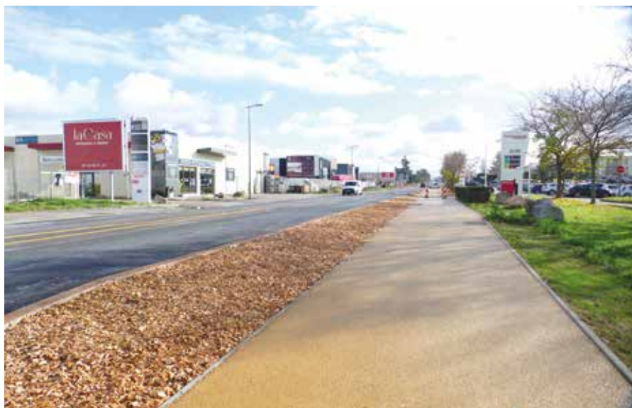
Travaux avenue Charles de Gaulle - Saint Bonnet de Mure
