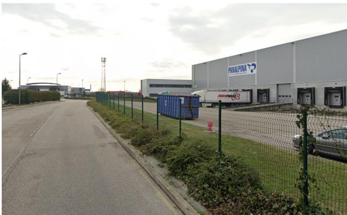
Voie interne de la ZAE Satolas Green
