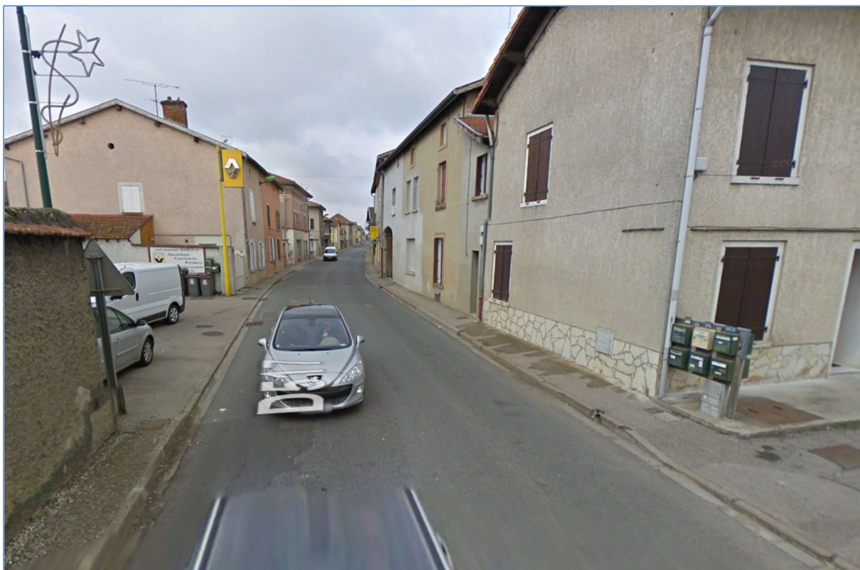
Photo avant travaux (Février 2011)
