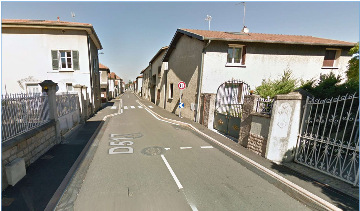
Photo après travaux (août 2017)
