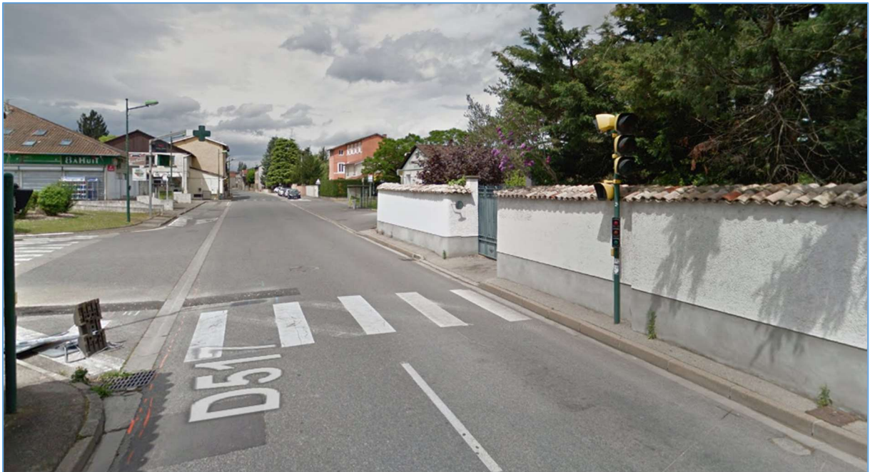
Photo avant travaux (Mai 2016)
