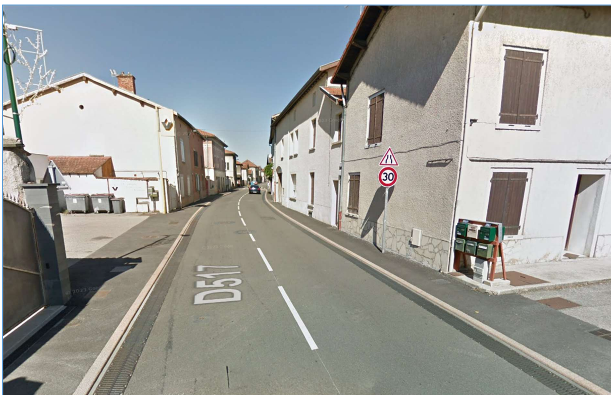
Photo après travaux (août 2017)
