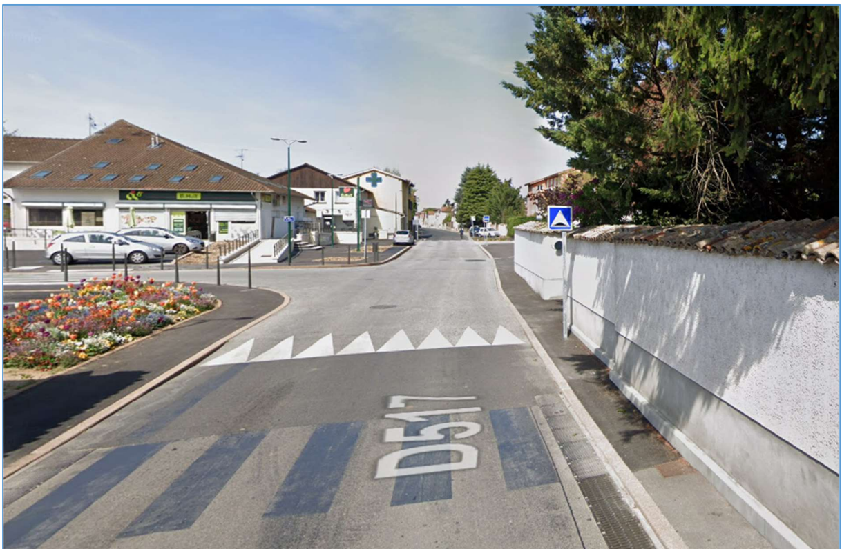
Photo après travaux (avril 2019)
