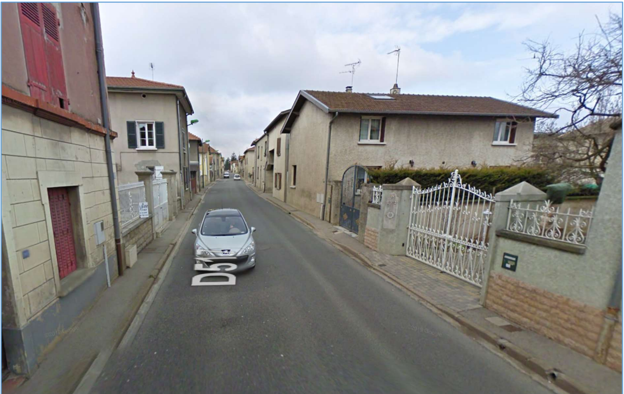
Photo avant travaux (Février 2011)
