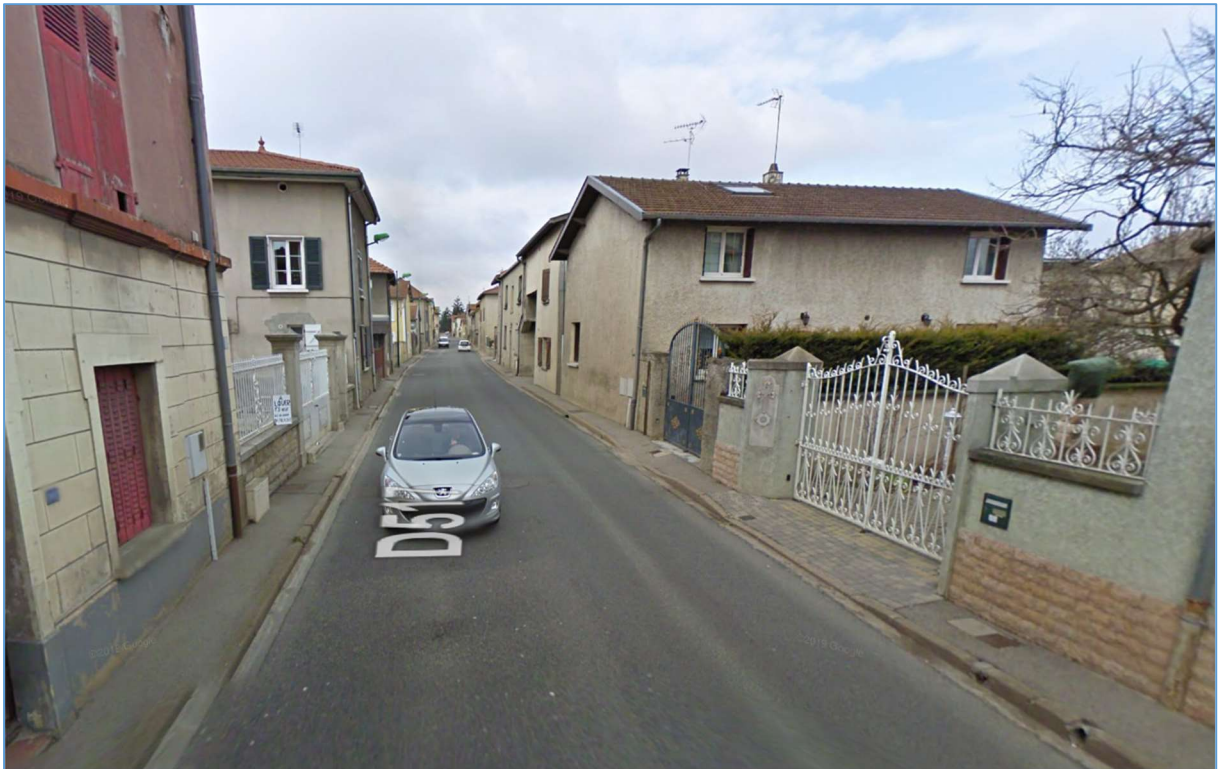
Photo avant travaux (Février 2011)
