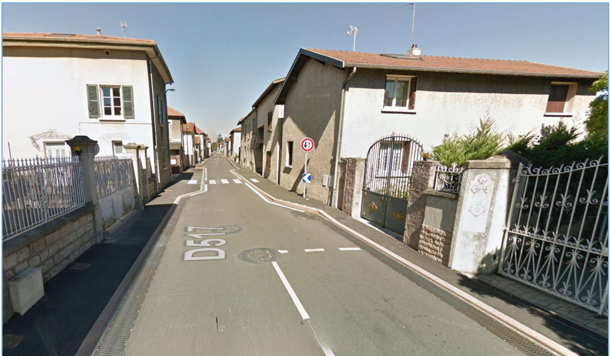
Photo après travaux (août 2017)
