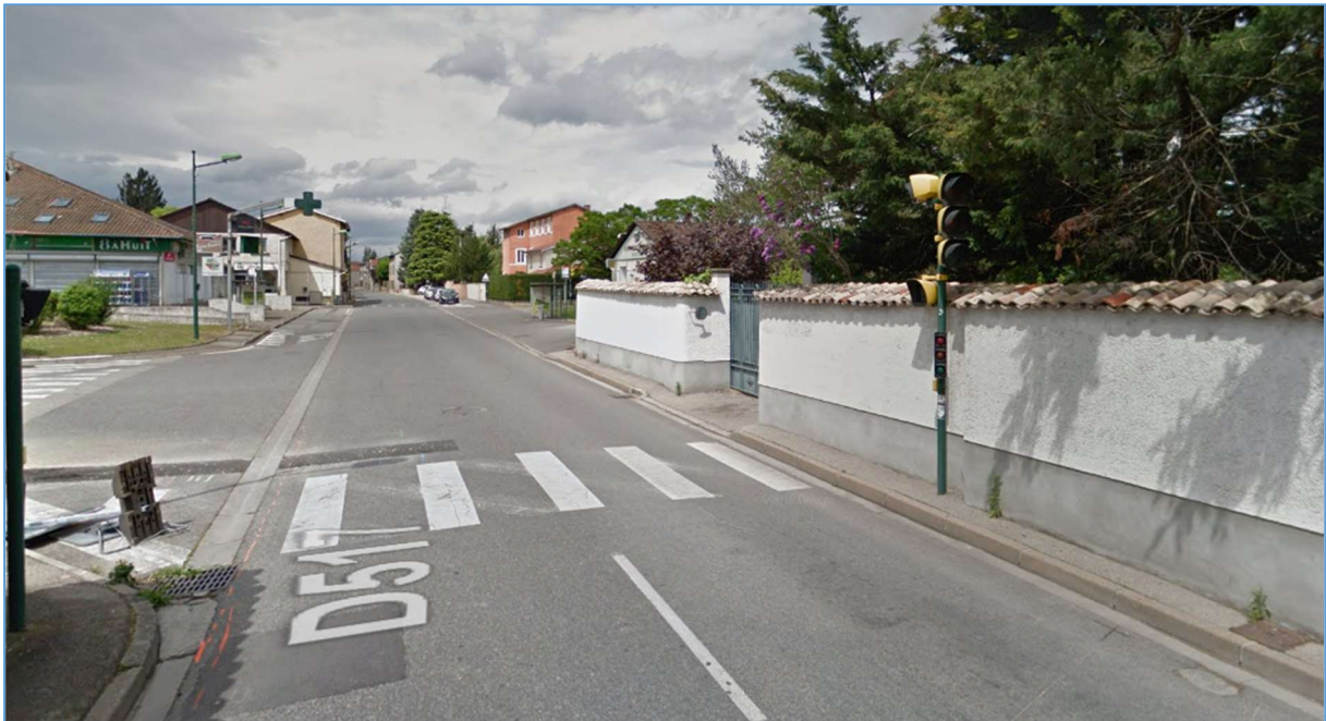
Photo avant travaux (Mai 2016)
