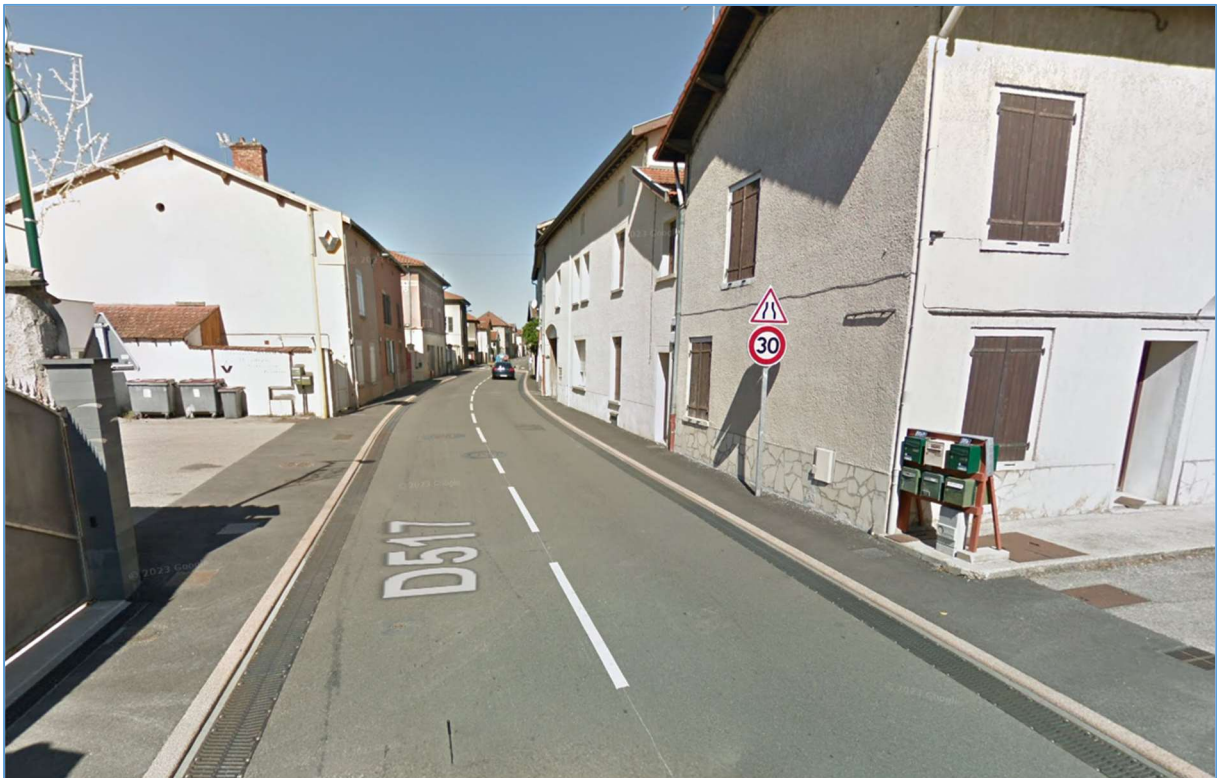
Photo après travaux (août 2017)
