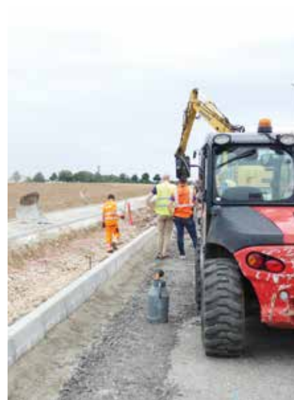
Travaux de requalification de la ZA Mi-Plaine à Genas
