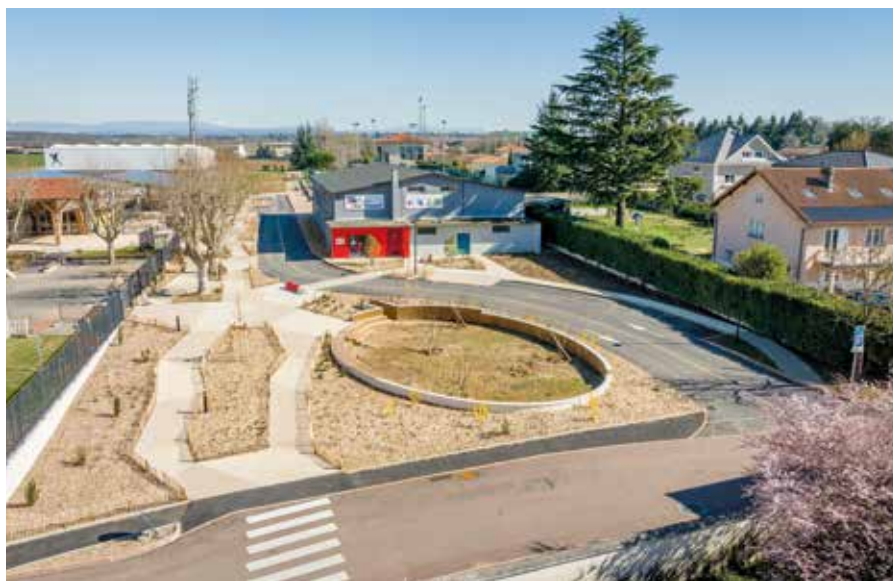
Aménagement de l'Espace Brissaud à Pusignan
