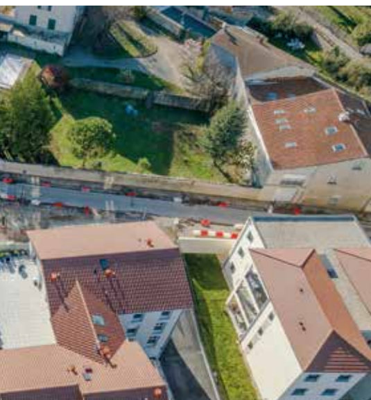
Travaux Route de Lyon à Colombier Saugnieu
